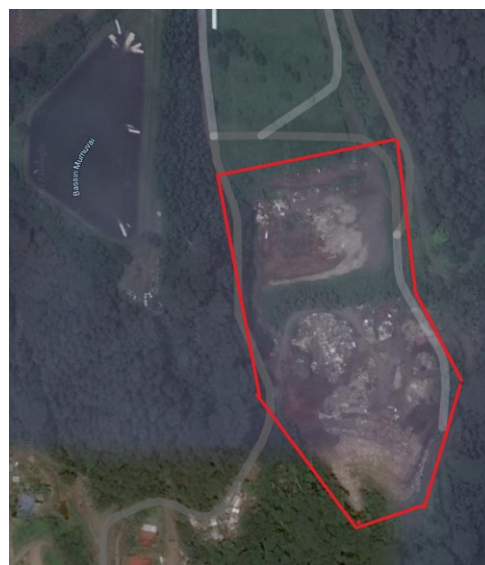
EMPRISE DE LA DECHARGE~ 5,5 HA
